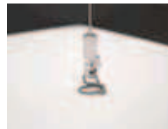
Abhängung mit Spiralfeder
